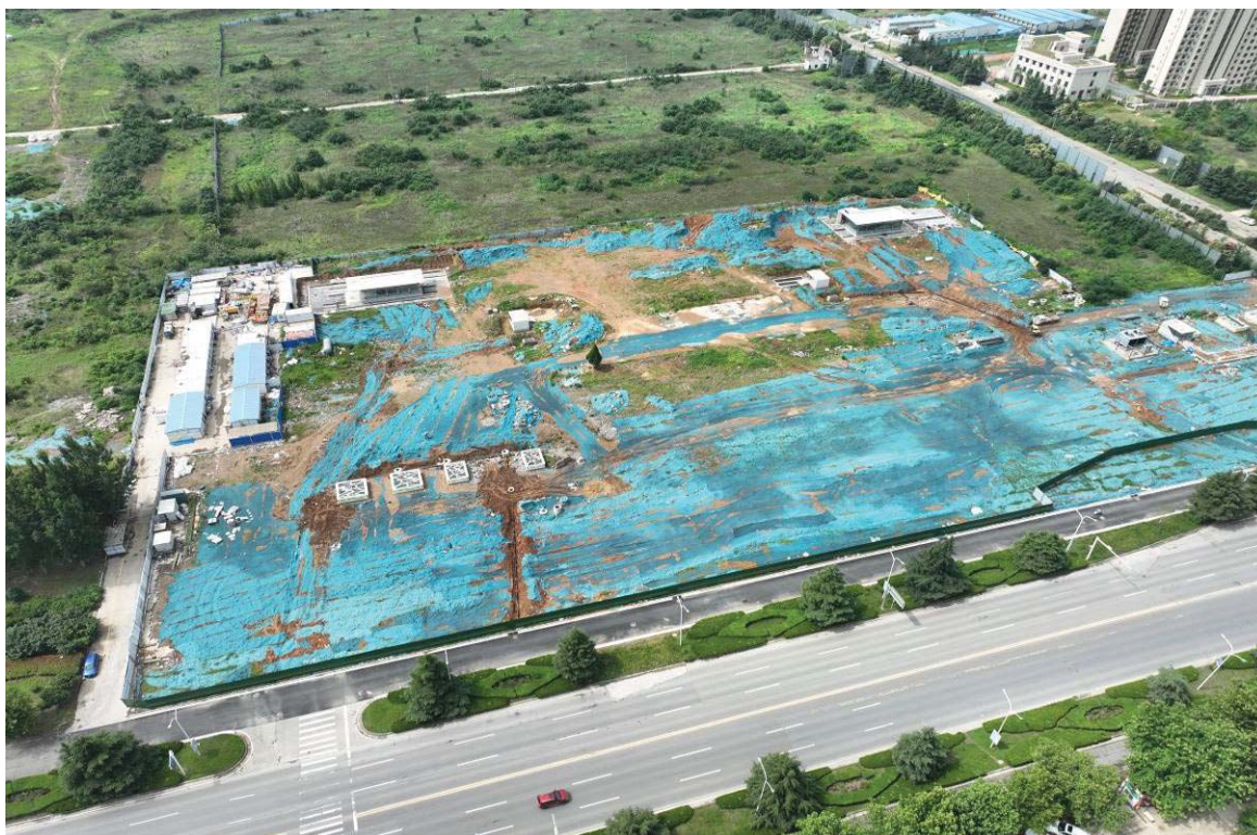
地铁 10 号线柳湖站施工场地
