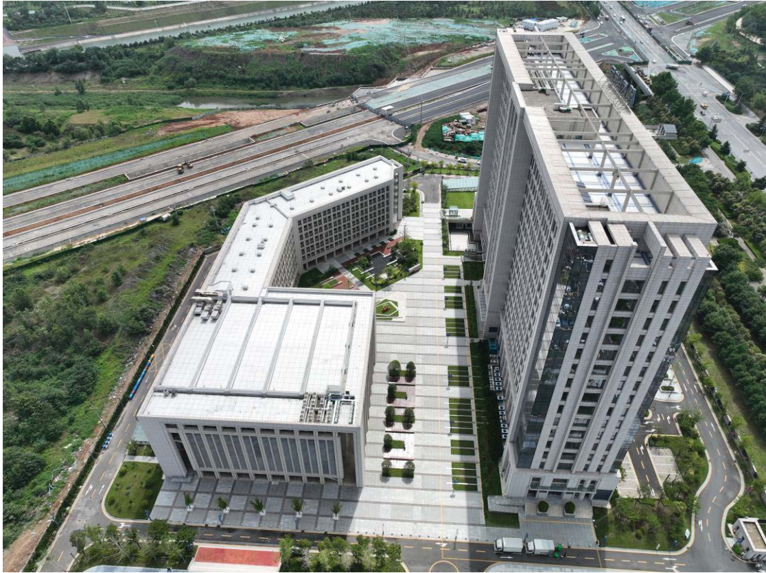
中原西路以北已建区域——中机六院
